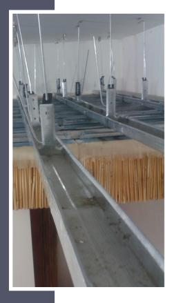
Akustik Reet Elemente bestehen aus einer Trägerplatte, auf der mit Spezialschaum die Schilfrohre fixiert sind.
