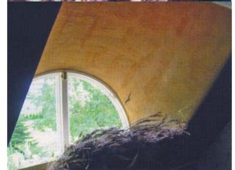
**Wenn Schilf als Dämmung benutzt wird, erhält es einfach einen Lehmschutz**
